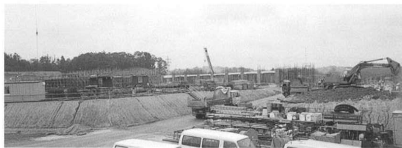
研究所建設工事風景
