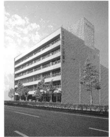
事務所を設置した京都商工会議所ビル
